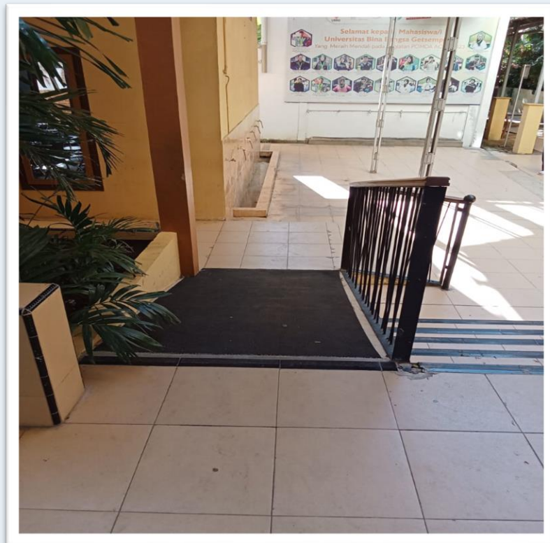
Ramp Disabilitas Lt.1 Menuju Mushola
