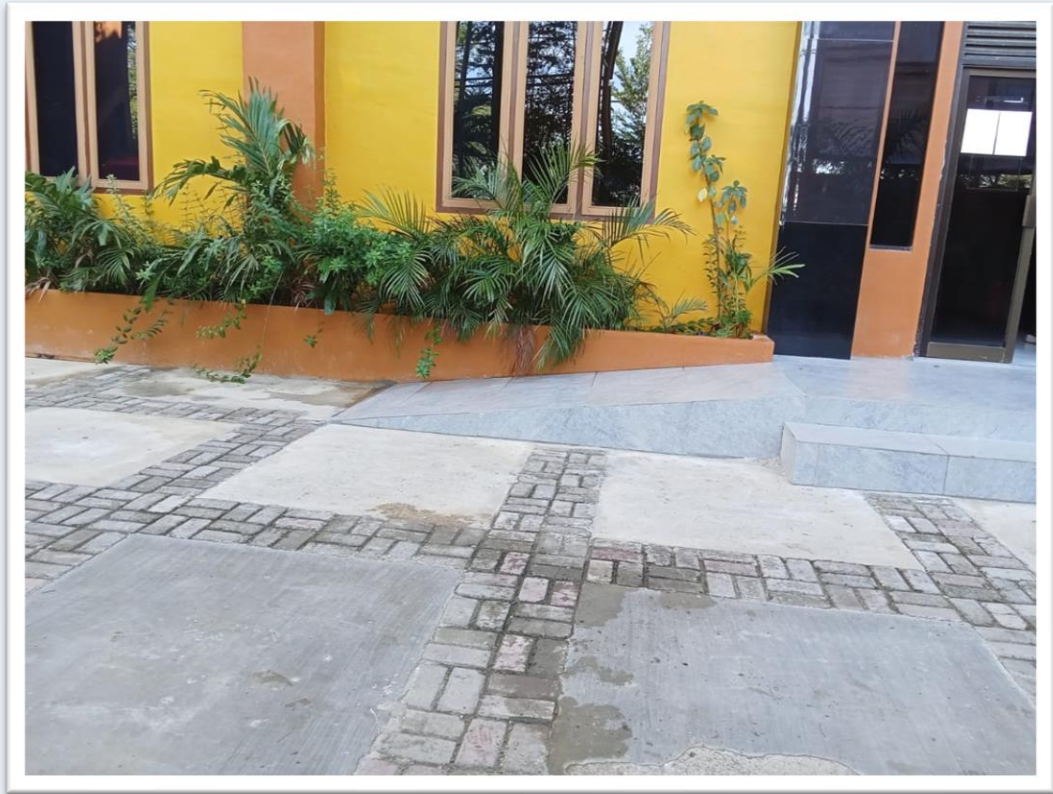
Ramp It.1 Menuju Gedung Lab.Kesehatan
