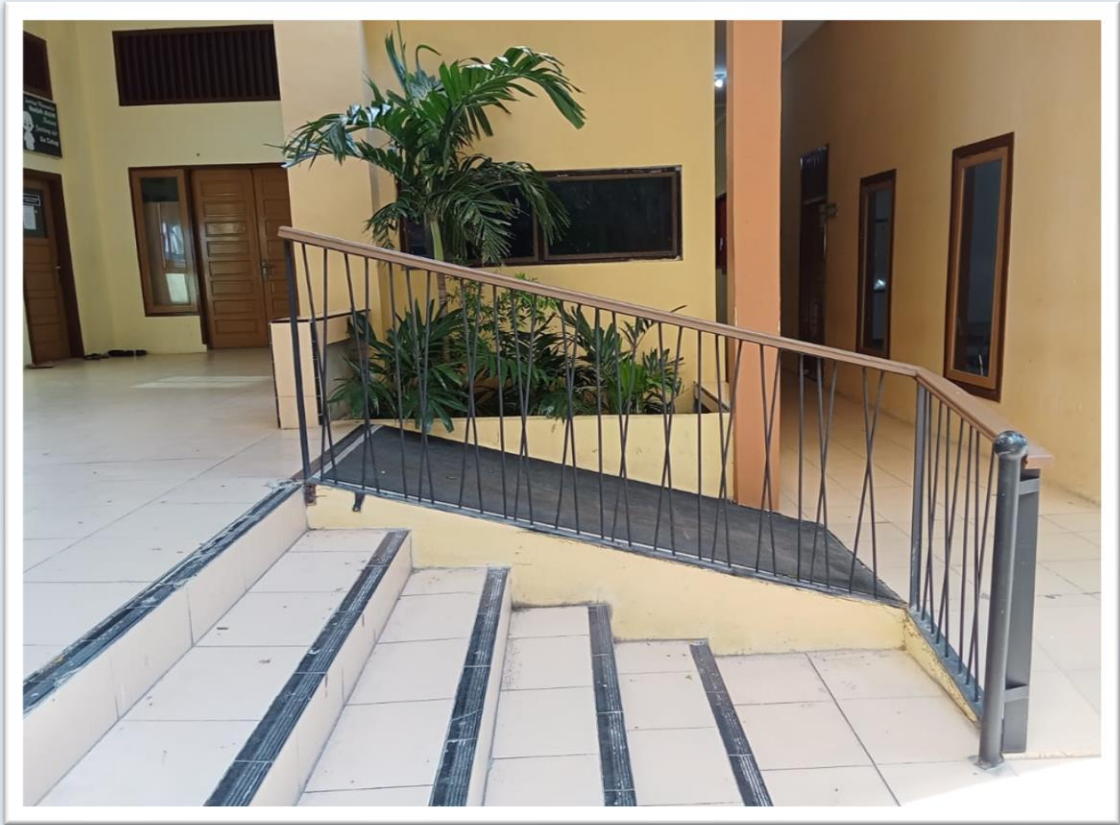
Ramp Disabilitas Lt.1 Menuju Mushola
